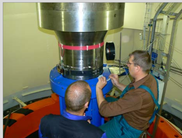
Instalace tenzometrů pro měření hydraulického axiálního tahu na hřídel turbíny techniky ČBE
