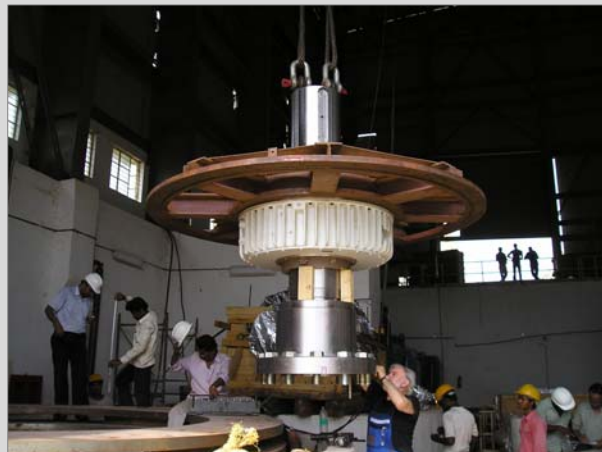
Čerpací stanice Gangaram – montáž spojky
