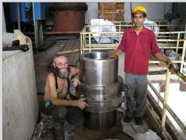
Čerpací stanice Gangaram – montáž spojky
