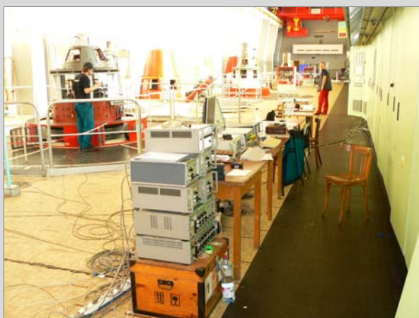
Měřící stanoviště ČBE ve strojovně VE Kamýk
