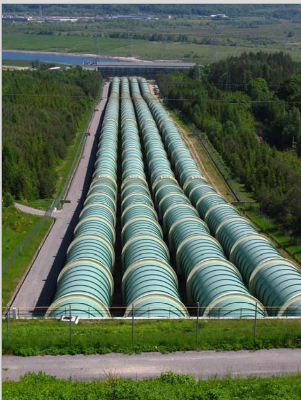
Příváděče - PVE Żarnowiec
