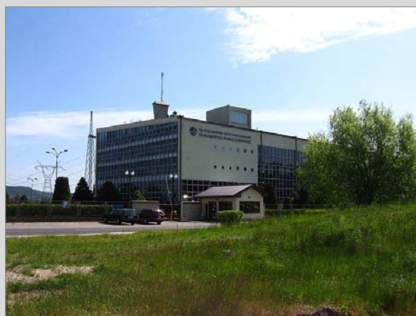
Správní budova a strojovna PVE Żarnowiec
